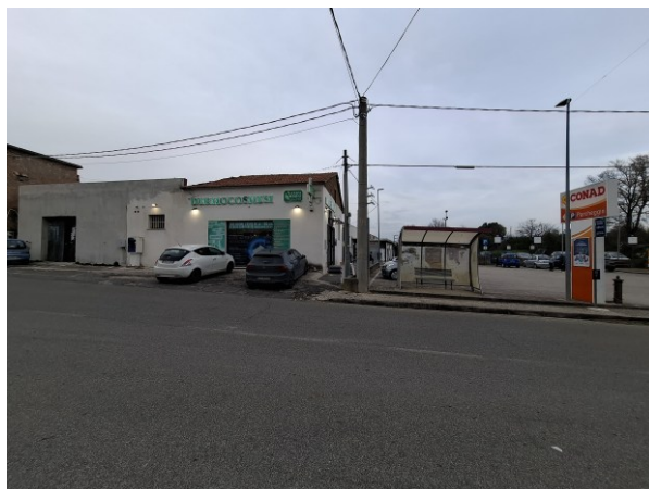
Figura 1 – Casali di Poggio Nativo: vista del tratto stradale antistante la farmacia, privo di attraversamento pedonale chiaramente individuato.
