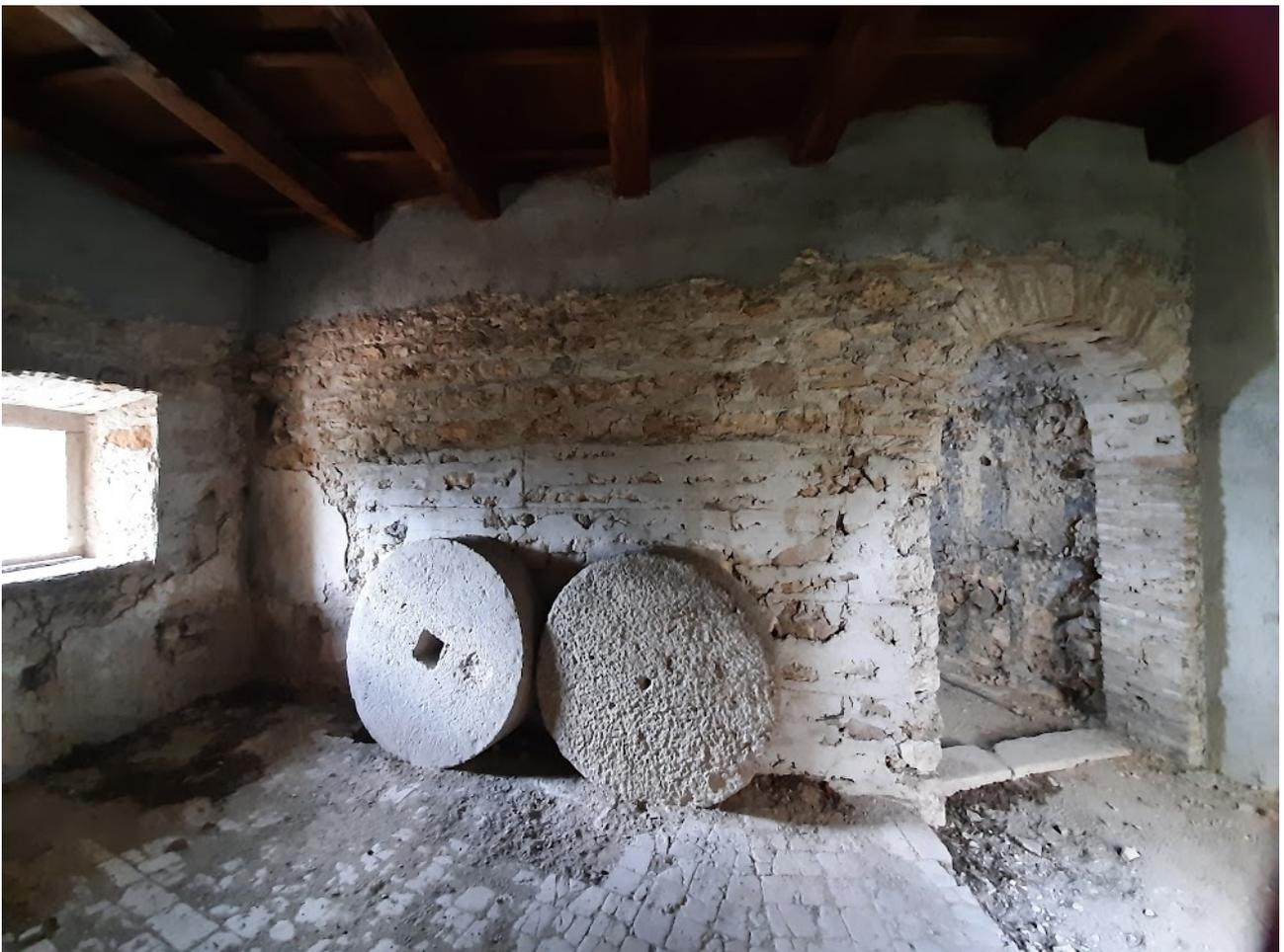
Stanza L. Nella quale si vedono sia i lacerti di intoaco originale sia le tracce delle casseforme utilizzate nella ricostruzione recente della muratura.
